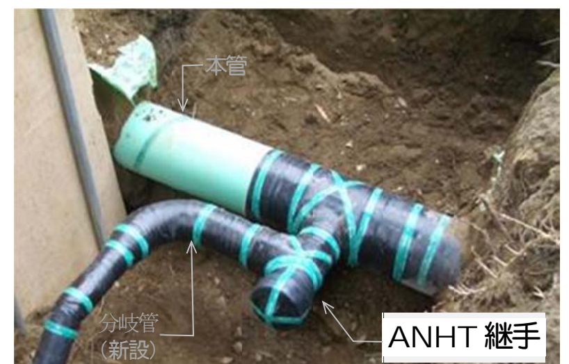
異径分岐の施工例
