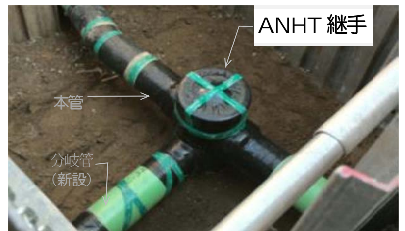
同径分岐の施工例
