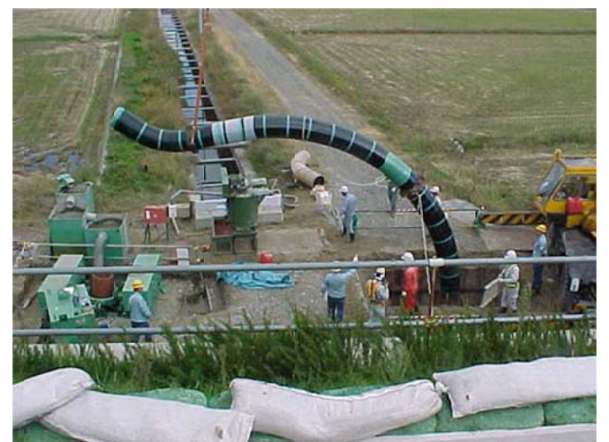
直引き工法配管例
