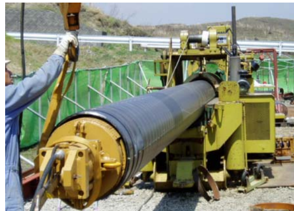
写真3 マンドレルの挿入
