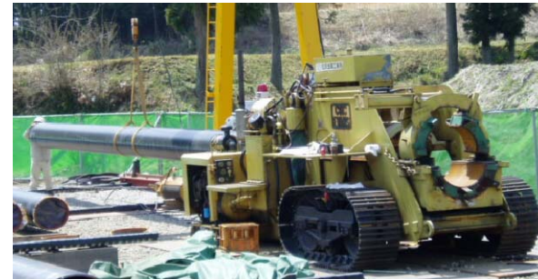
写真2 装置にパイプをセット
