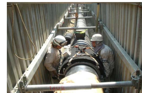
写真4 自動塗覆装装置の装着状況
