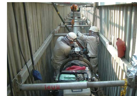
写真3 MAG 自動溶接装置の装着状況
