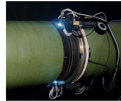
写真1 自動 MAG 溶接装置
