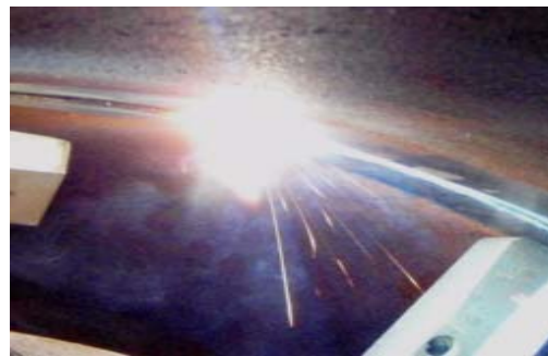
裏波溶接状況
