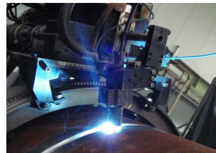
溶接状況(外面)
